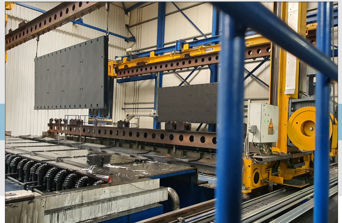
Die LKW-Wechselbrücken erhalten an Warenträgern hängend eine KTL-Beschichtung
