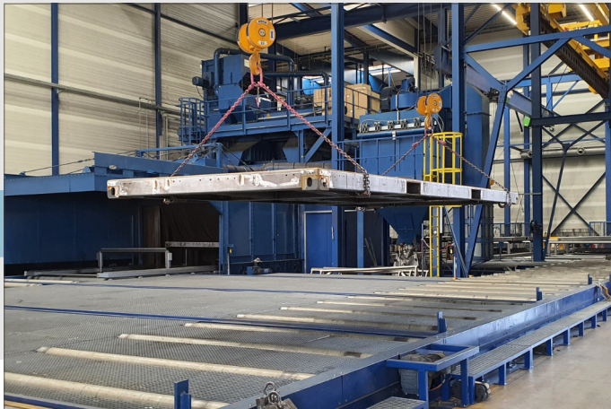
Ein Kran befördert die angelieferten Rohbauteile in die integrierte Strahlanlage
